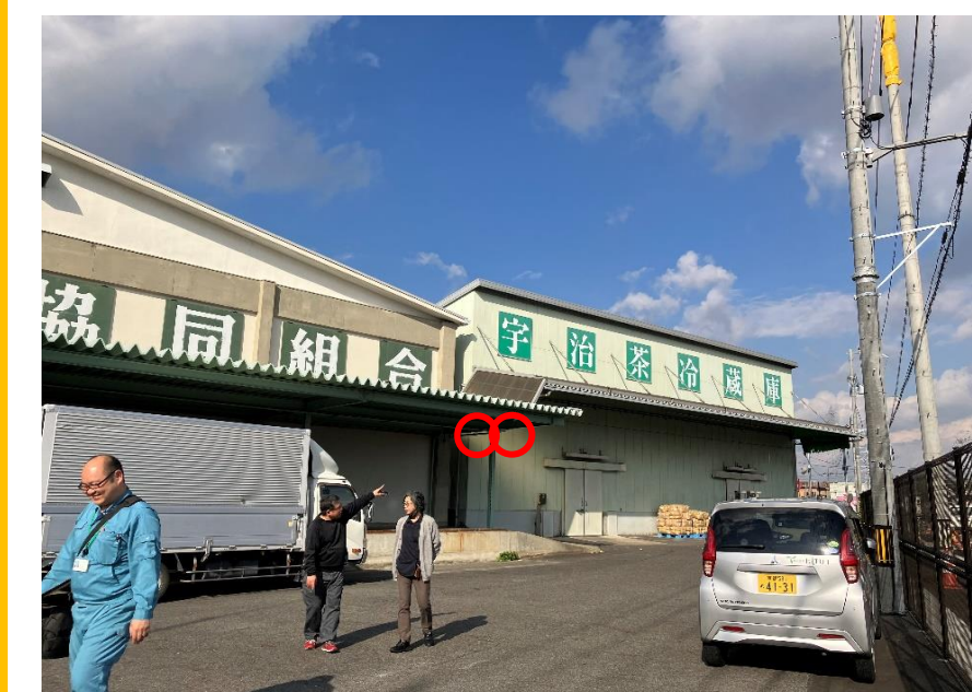
カメラC 02 (左側)、カメラC 03 (右側) 設置位置
